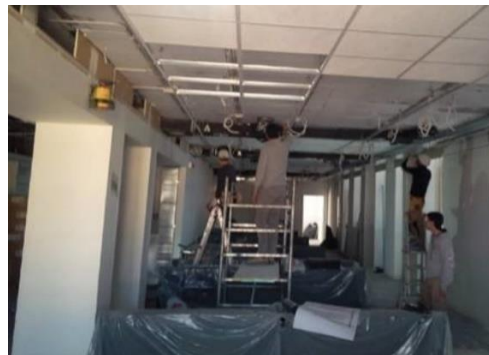
Figura 8.6 - Particolare installazione controsoffitti
