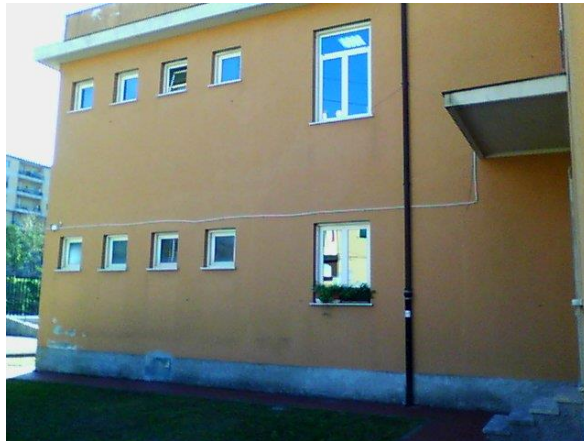
Figura 4.2 - Particolari della facciata
