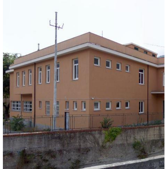
Figura 1.1 - Vista della facciata esposta a Sud -Ovest
