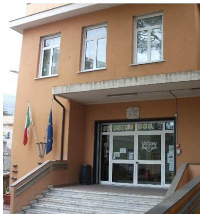
Figura 4.5 - Particolare dei nuovi serramenti del Piano Primo
