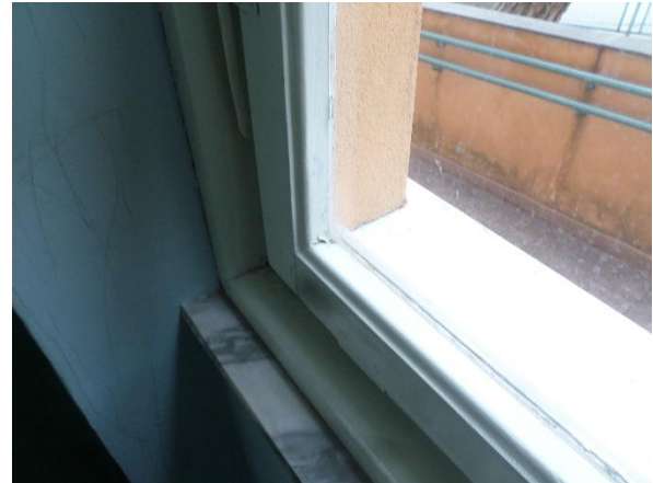
Figura 4.1 - Particolare dell'involucro murario al piano terra
