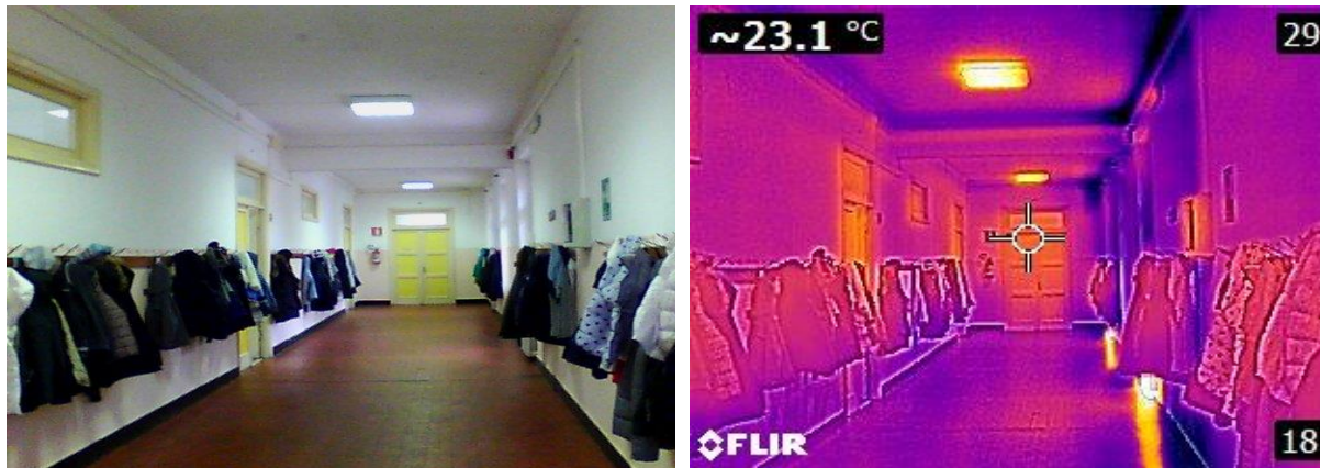
Figura 4.3 – Rilievo termografico della parete
