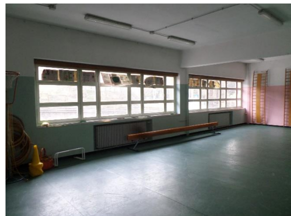
Figura 4.4 - Particolare dei serramenti della palestra al Piano Terra
