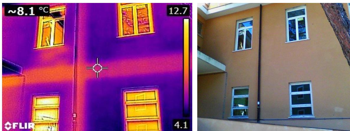
Figura 4.6 – Rilievo termografico dei serramenti
