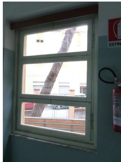
Figura 8.4 – Esempio del vecchio tipo di infissi presenti
